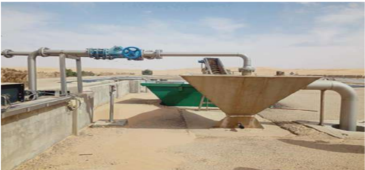
Figure II.10: Système de dessablage
