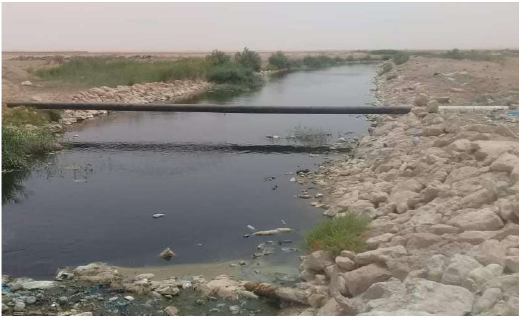
Figure 4.1 : Tronçon d'acier entre Bouamer et Bamendil
