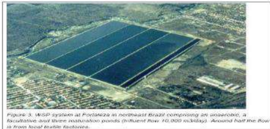
الشكل (16): محطة معالجة 10000 م 3 /يوم نصفها صناعي (البرازيل) برك تثبيت لا هوائية ثم اختيارية وثلاثة برك إنضاج [28]
