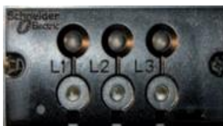
Fig. 3.19 : Indication de la présence de tension
