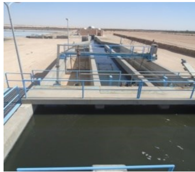
صورة 05: إزالة الرمال Step ouargla
