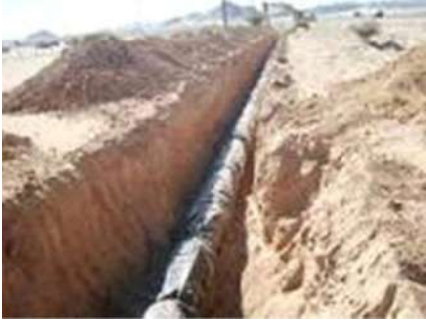
صورة رقم 12: صورة تبين كيفية وضع قنوات المياه المستعملة.
