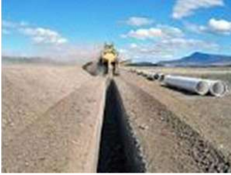
صورة رقم 11: صورة لخندق قبل وضع القنوات.
