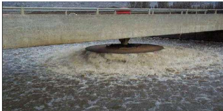
Figure III.5 : Turbine de surface à vitesse lente.
