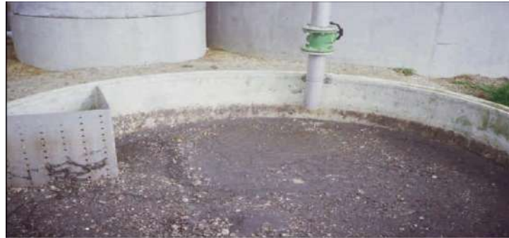
Figure II.4 : Extraction du sable d'un dessableur – dégraisseur.
