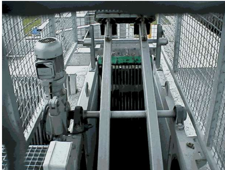
Figure III.1: Dégrilleur courbe.
