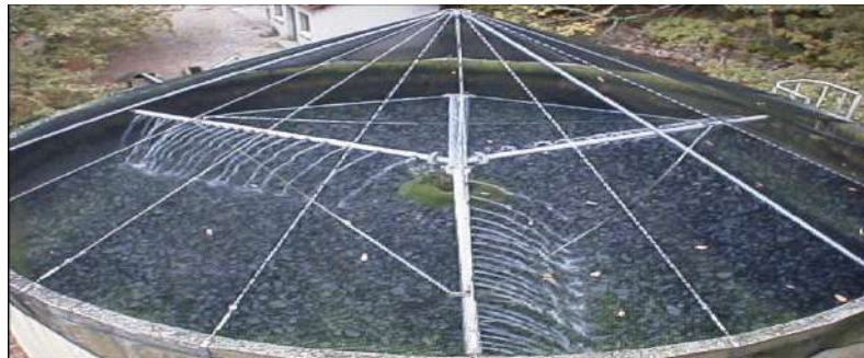
Figure III.7 : Lit bactérien avec garnissage traditionnel.
