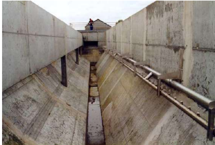
Figure III.2: Dessableur rectangulaire à insufflation.
