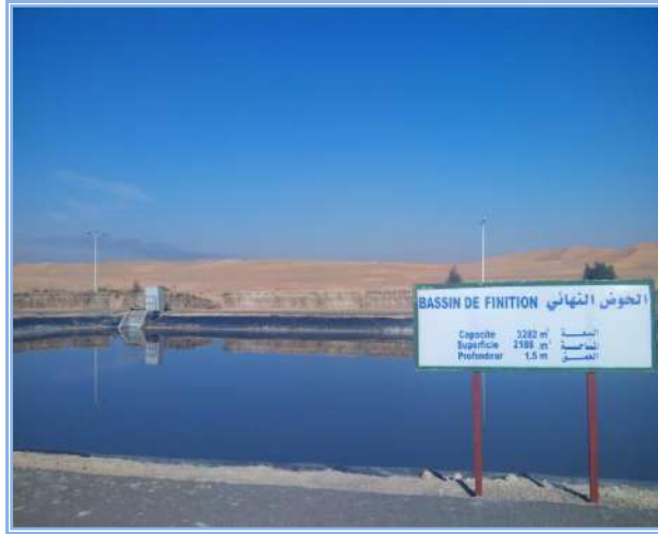
Photo 07: Bassin de finition
