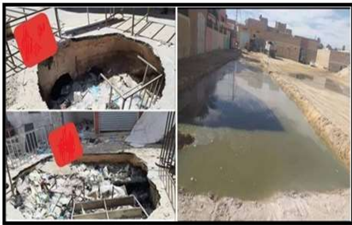
Figure.III 6 : La Détérioration des routes et des complexes résidentiels dans la ville de Touggourt
