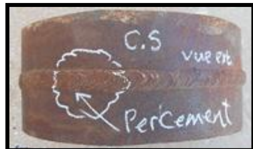
Figure II.4.4 : Percement du cordon soudure (vue externe)
