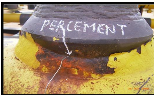
Figure II.4.1 : Percement du cordon soudure du té de gare
