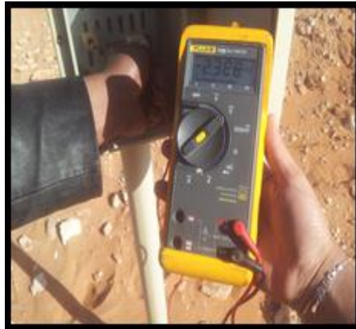
Figure III.27 : Mesure du potentiel d'une conduite enterrée à l'aide d'un multimètre
