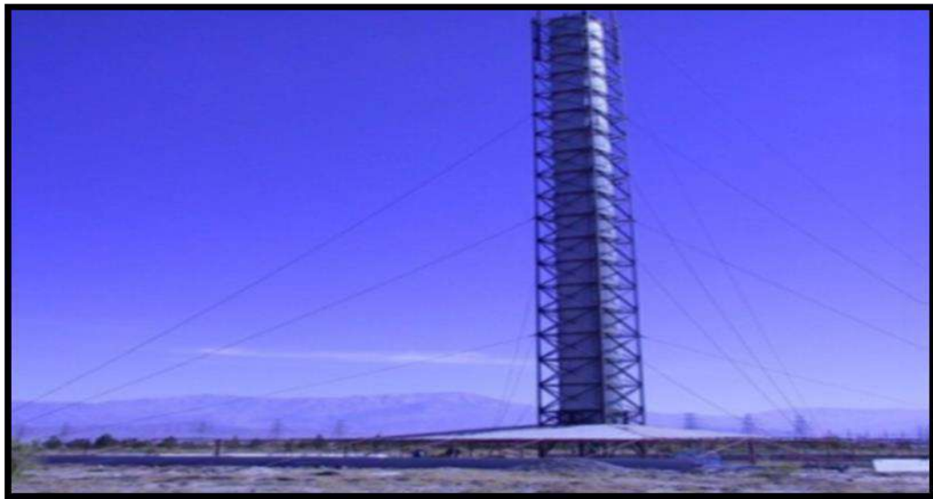
Figure II. 12. Photo de la centrale à cheminée solaire pilote de Kerman en Iran [20].
