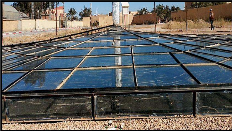
Figure III. 4. le collecteur de cheminée solaire.
