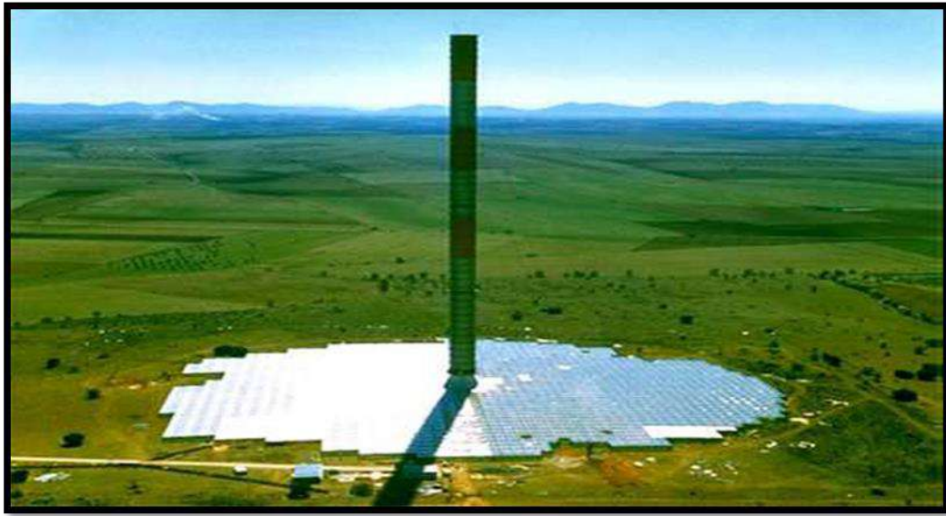
Figure II. 10. Photo des différents compartiments à cheminée solaire de Manzanares de la centrale [20].
