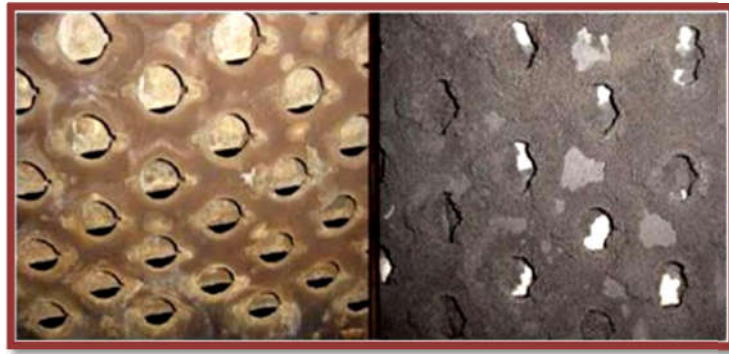
Figure II.1 : Exemple de corrosion sur un plateau de distillation de raffinerie. [6]
