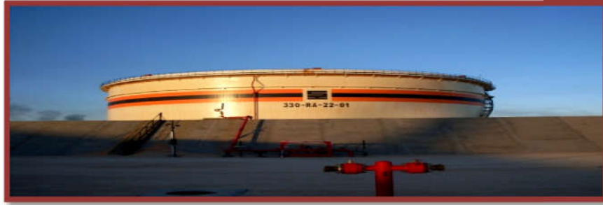
Figure. I.5 : Bac de stockage
