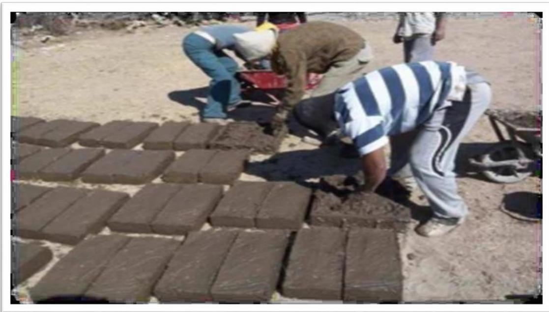
Photo I.1 : Moulage et séchage des blocs adobes
