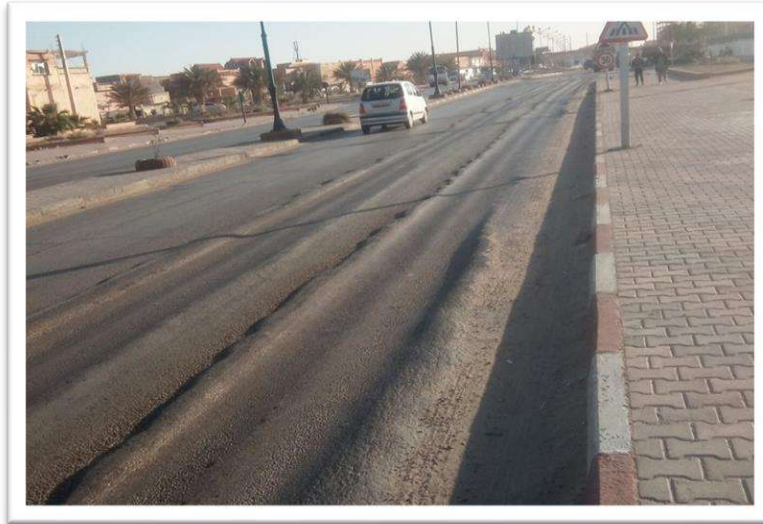
- الشكل رقم (8) صورة لظاهرة التحدد على سطح الطرقات -
