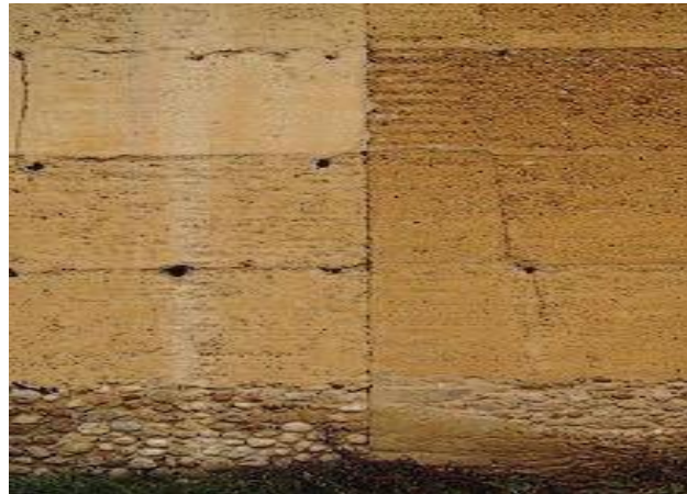
(I -15): Mur en pisé [18].
