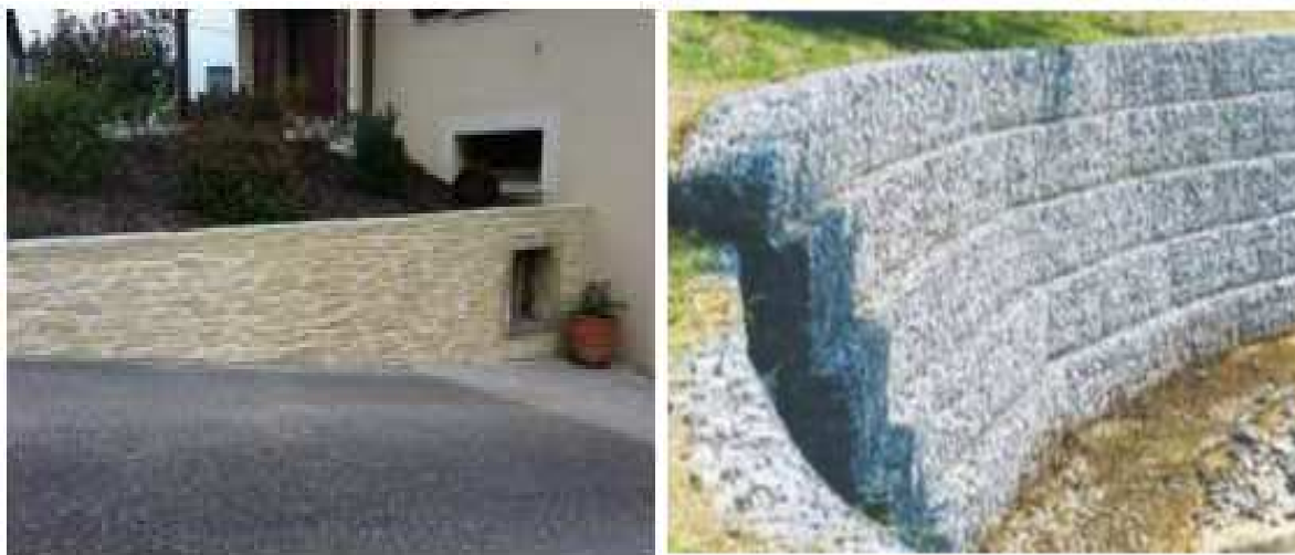
Figure 1-1 : Les ouvrages de soutènement. [30]
