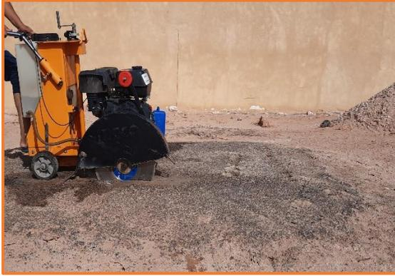
**Figure III.7 : Découpage de la couche de surface.**
