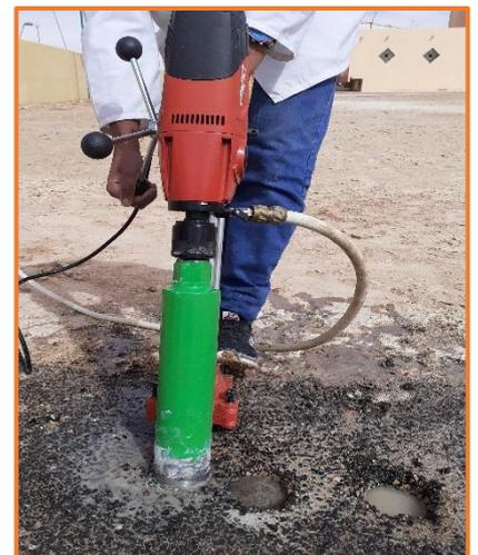
**Figure II.4 : Exécution du carottage**
