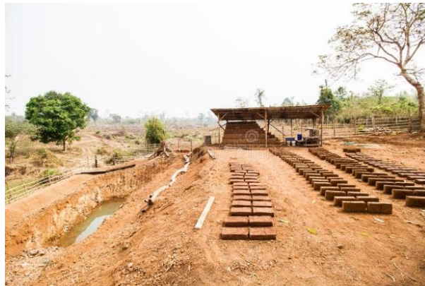
Figure I.6 : Moulage et séchage des blocs adobes.
