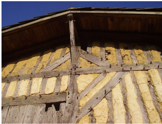
Figure I.9 : Le torchis - Halte d'accueil en éco-construction.
