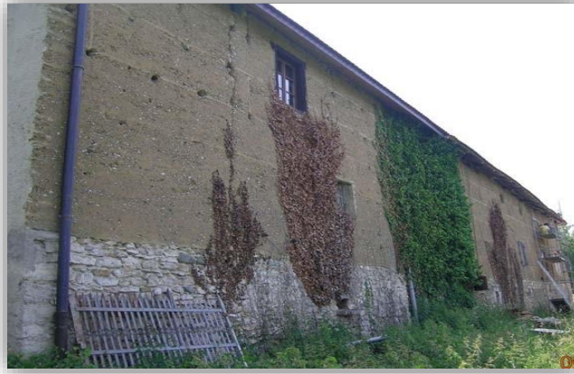
Figure I.11 : Maison ancienne de 130 ans.
