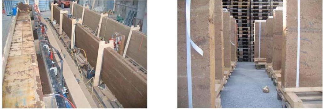
Figure I.17 : Préfabrication des pisés dans une usine.
