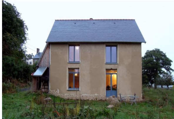
Figure I.8 : La maison en Bauge.
