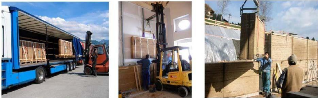
Figure I.18 : Transport et mise en œuvre des éléments préfabriqués.
