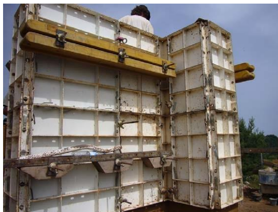
Figure I.14 : Coffrage métallique du pisé moderne.
