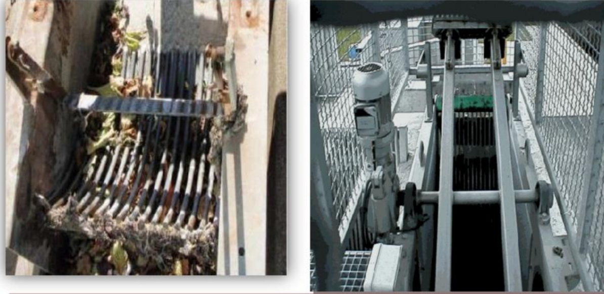
الشكل (03): غربال حديدي لنزع الأجسام الكبيرة
