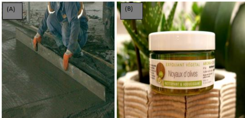
Figure I.17 :a), le mortier Mixxol est composé de 49% de noyaux d'olive et b) Un cosmétique à base de noyau d'oliv
