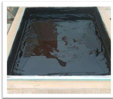
**Figure II.21 :** Sac de tissu fixé dans le bassin. **Figure II.22 :** Le charbon dans le bassin.
