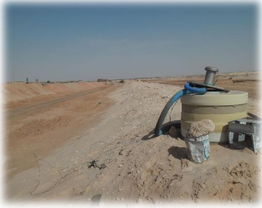
الشكل II-03: الإعتداء على قناة التحويل و تعريتها . [27]
