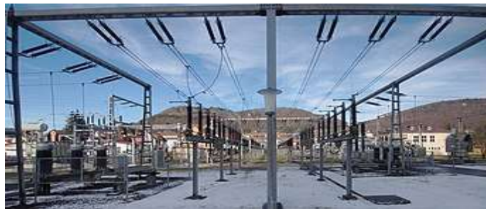
. Figure 1.4: JdB avec conducteurs flexibles
