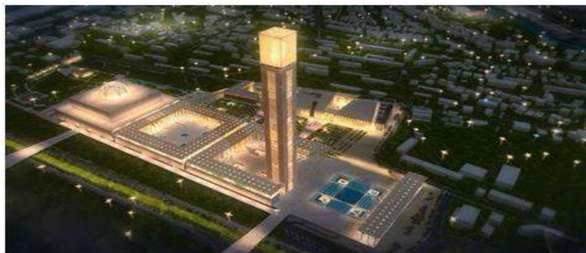
Figure 1.13: The Djamaâ el Djazaïr Mosque trigeneration project [Stratégie, 2018]
