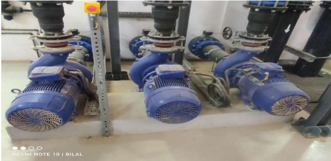
Figure I.7 : Pompe d'alimentation des filtres à sable
