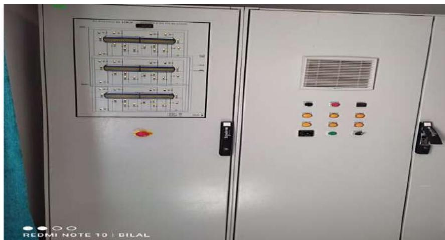
Figure I.2 : armoire de filtre à sable
