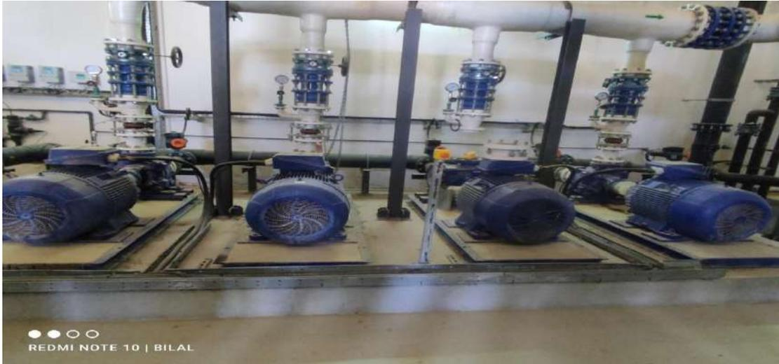
Figure I.9 : Pompe à haute pression pour osmose inverse
