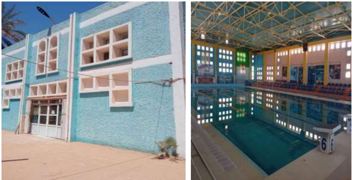
Figure N°7 : Piscine semi-olympique 18 Février Ouargla
