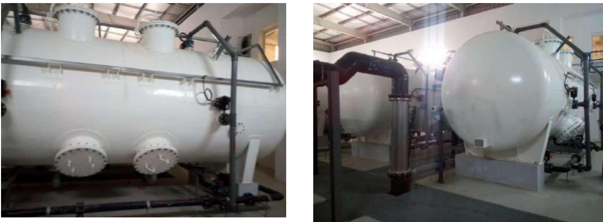
Figure 25 : les filtres à sable de la station d'IFRI GAR)- Mécanismes de filtration
