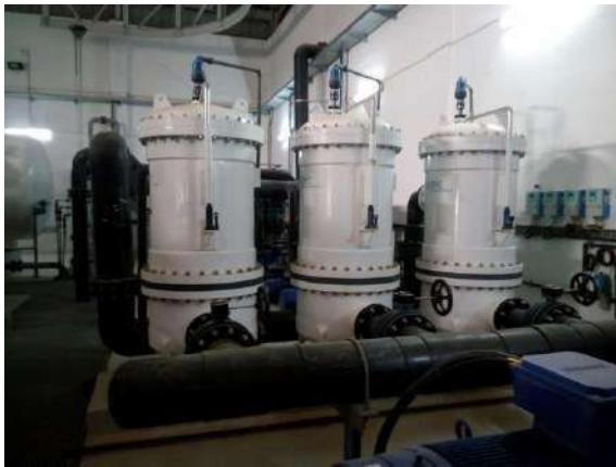
Figure26: Filtres à cartouches de la station d'IFRIGARA.
