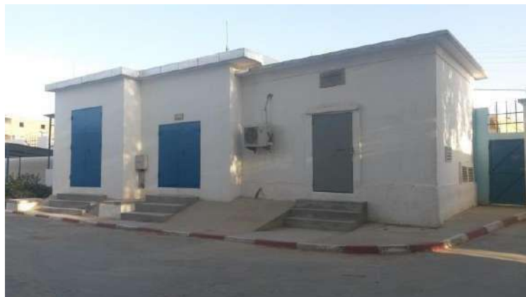
Figure24:Bâtiment Locale d'énergie à la station d'IFRI GARA.
