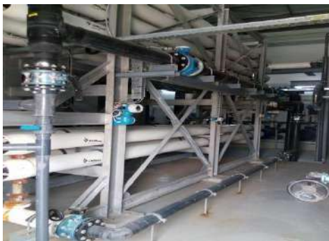
Figure29: Unité d'osmose et de l'osmose inverse
