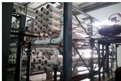
Figure29: Unité d'osmose et de l'osmose inverse
