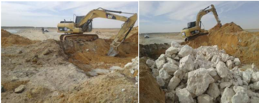
Fig9.4.1 Schémas du préparer le fond de forme
