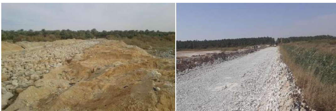
Fig9.4.2 Schémas du préparer le fond de forme
