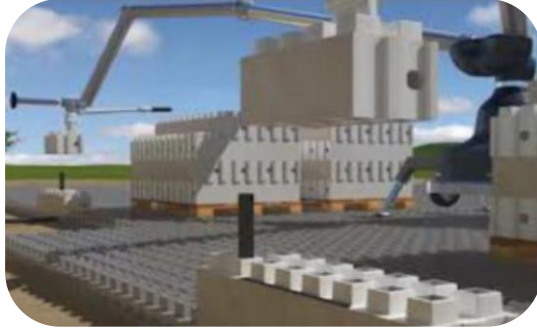
الشكل(1.1): صورة توضيحية لطريقة تركيب الطوب الذكي[8]
