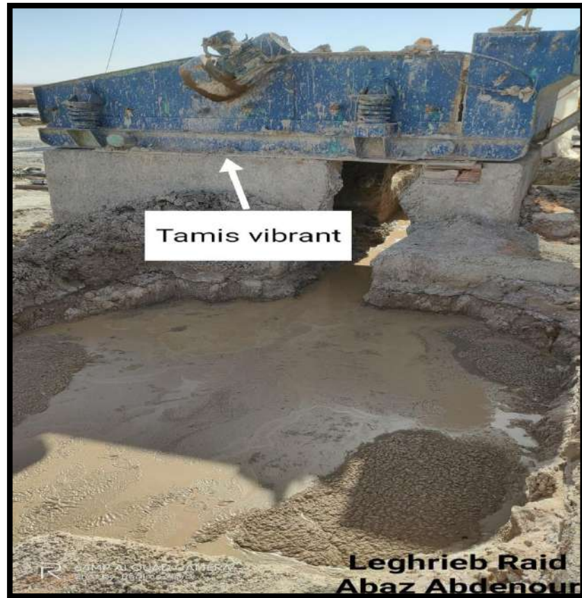
Photo N°21 Le tamis vibrant sur le chantier.
