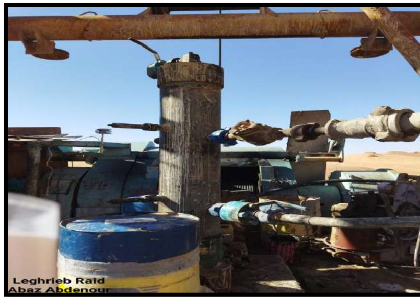
Photo N°33: La tête de cimentation.
