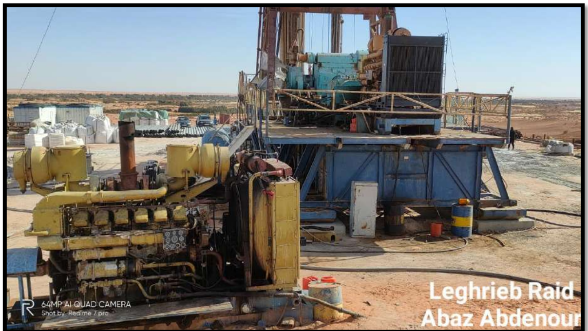
Photo N°16: Installation de Chantier de forage Hassi Lekhfif.
