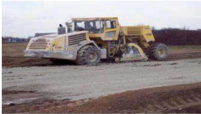
**Figure 02 : Chantier de traitement du sol au ciment.**
