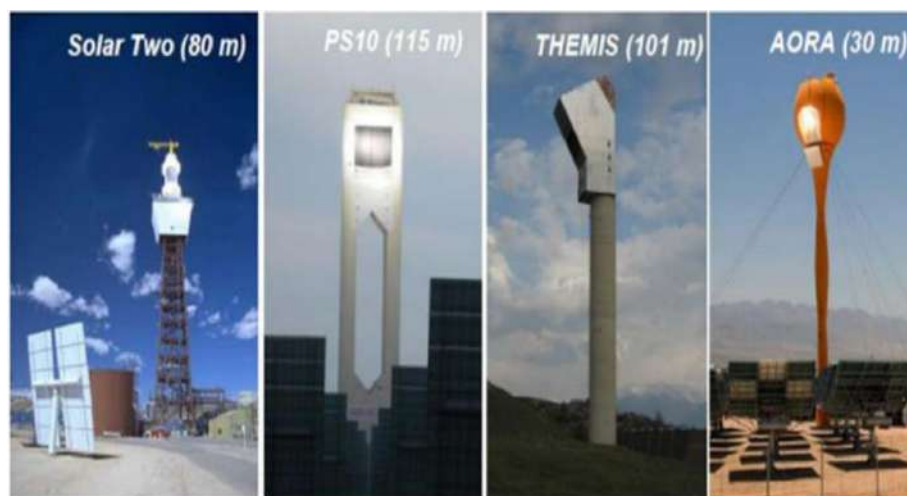
Figure 2.12 : Exemples de tours de centrales solaires [24]
