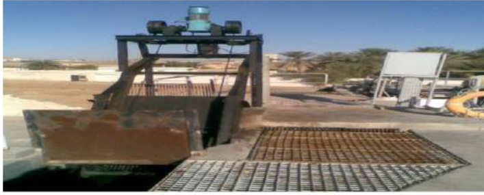
الشكل (01) : وسيلة ميكانيكية لنزع المواد الصلبة.
