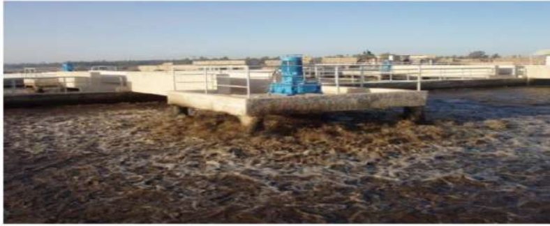
الشكل (03) : أحواض تهوية المياه المستعملة.
