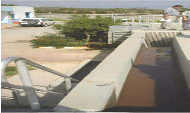
Figure 5: Le Dessableur simple à canaux gravitaires
