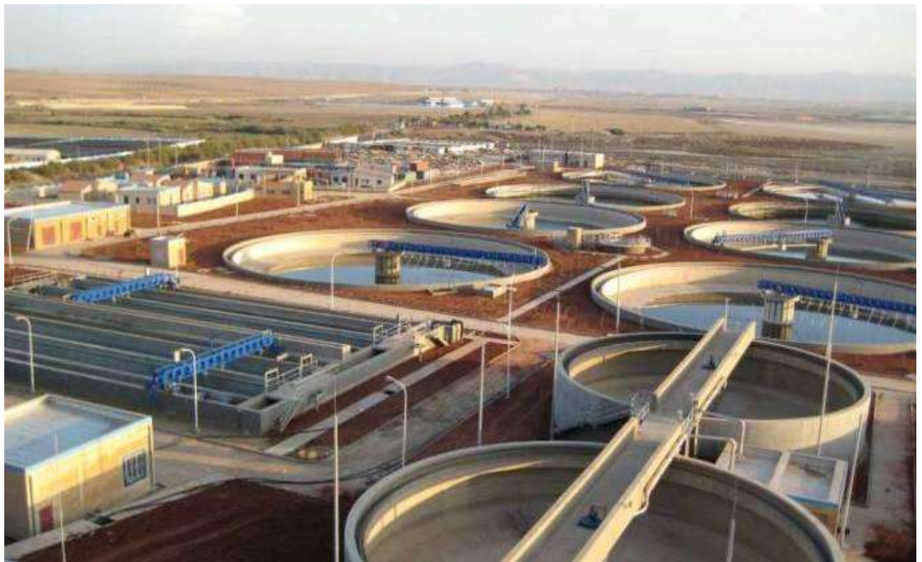
Figure. II.3. photo aérienne de la station d'épuration (HASSI MESSAOU D 2017)
