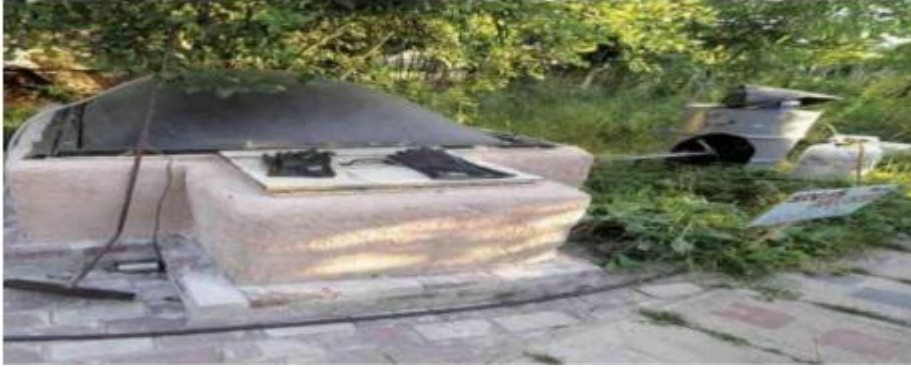
الشكل (2. III) : وحدة انتاج الغاز الحيوي من عملية التخمير اللاهوائي
