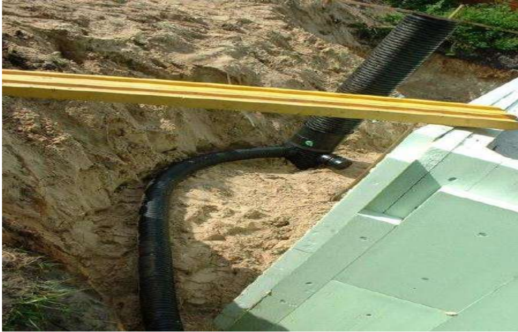
الشكل 1-1: صورة للأنبوب المبادل الحراري [1]
