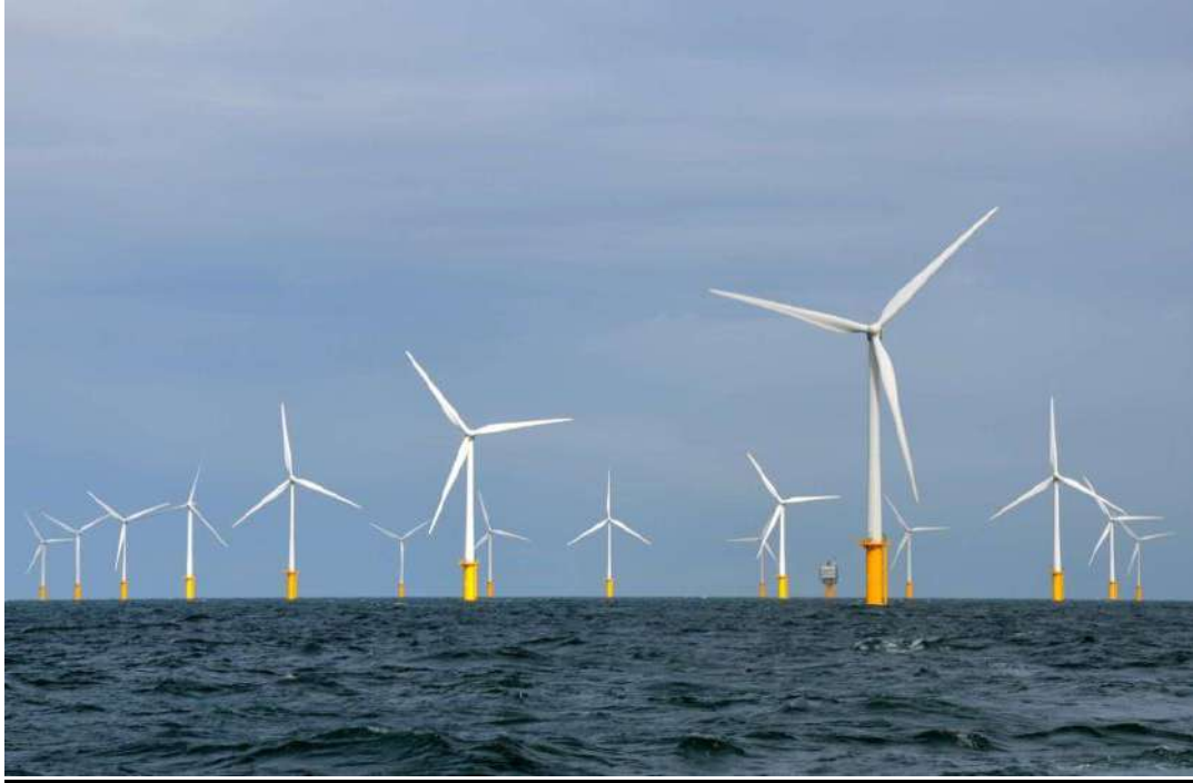
Figure I. 14 : Centrale éolienne au Royaume-Uni
