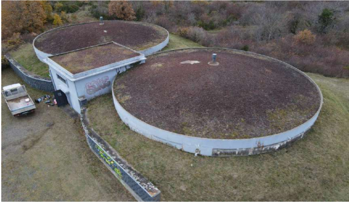
Figure II 2 : Réservoir semi enterré
