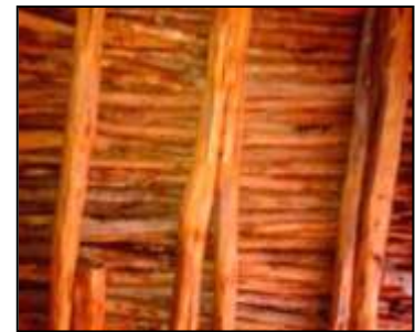
Photo 3.- Bois utilisé pour la construction des maisons. (Hili A., 2021)
