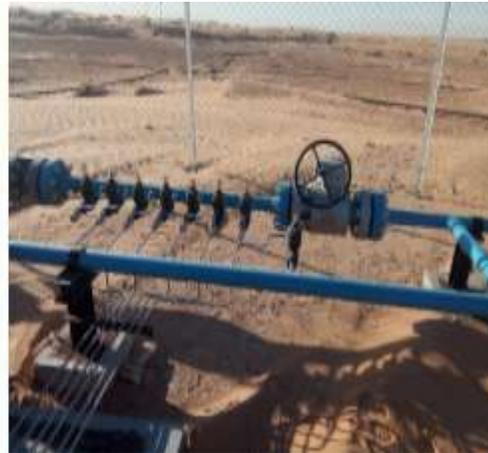
Injection des inhibiteurs
