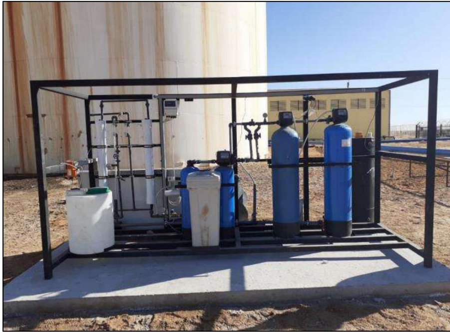
Figure III.3 : Unité pilote de traitement d'eau au niveau de site TAM a TFT
