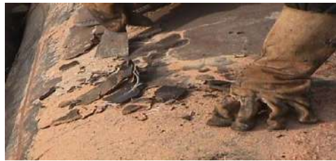
Figure (III.5): décapage manuel(STT)
