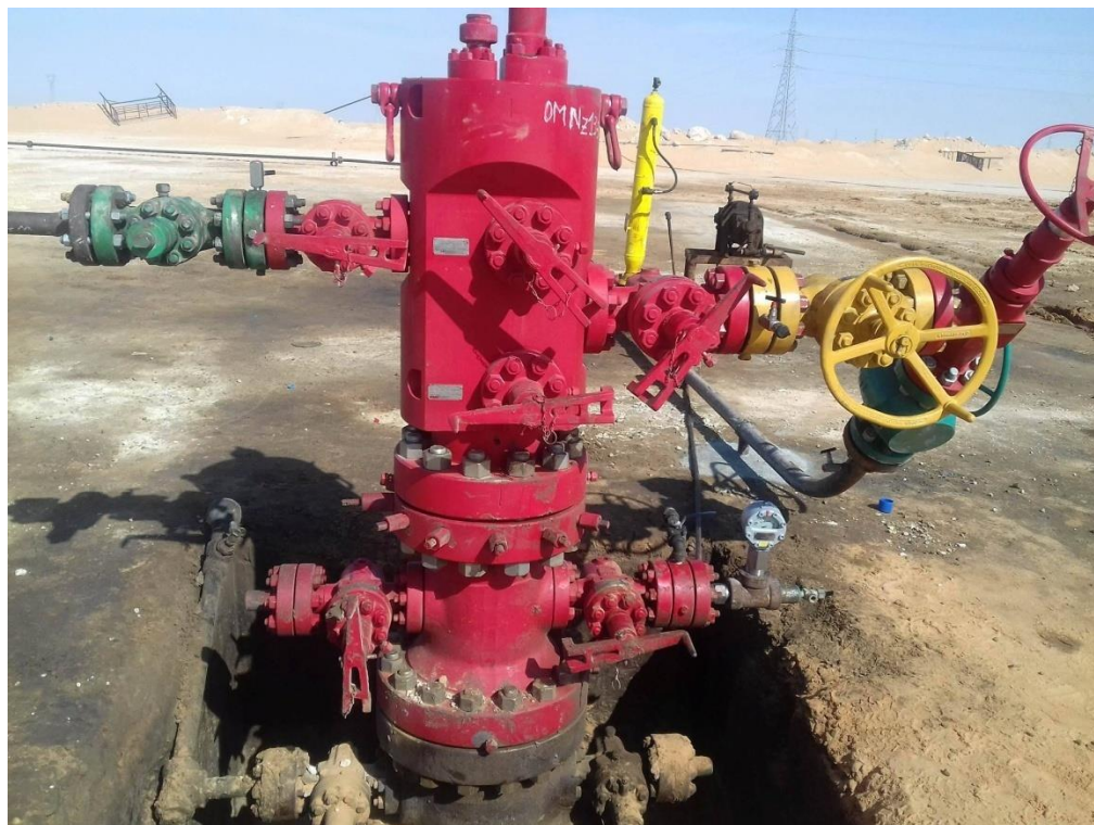
Tete de puits de la complétion parallèle (OMJZ742)
