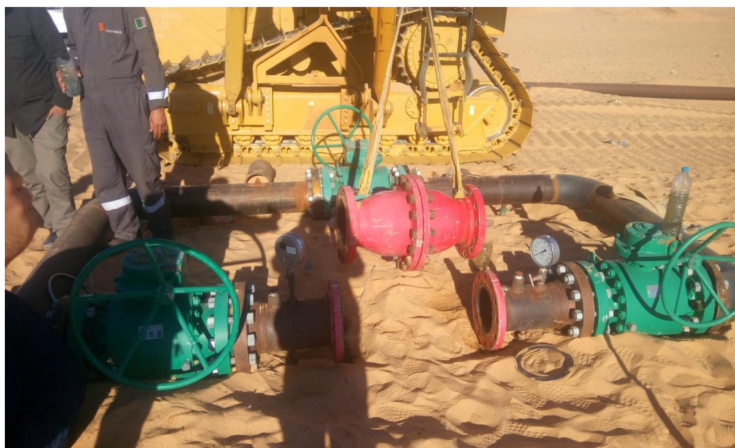
Figure IV.6 : Installation de l'outil ENMAX sur la ligne du puits MD 525. [22]
