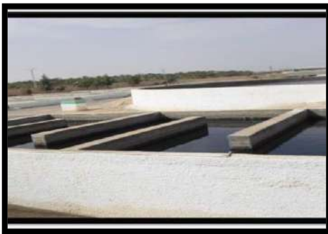
الشكل II.8: احواض الكلورة
