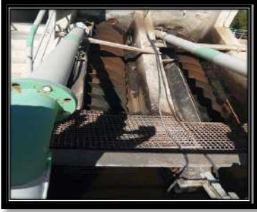
الشكل II.7: المضخة الحلزونية
