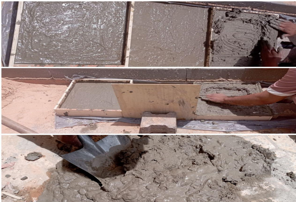
Figure III.2 : Travaux de béton.
