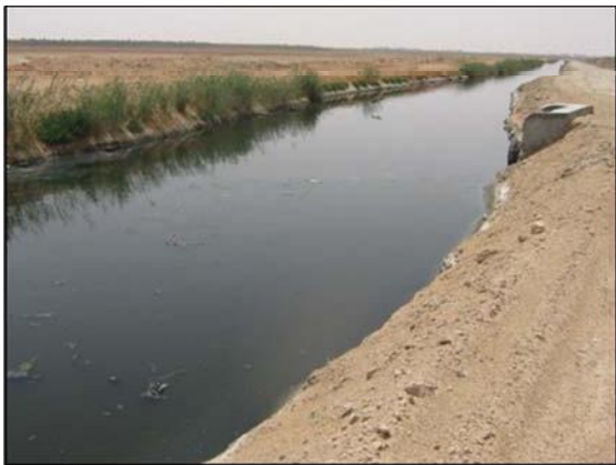
Fig.6.: Élargissement brusque des talus
