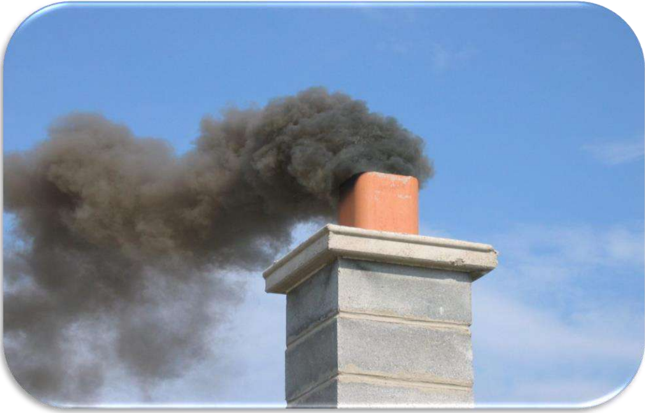
الشكل رقم 4: صورة تبين الانبعاثات من مدخنة المباني
