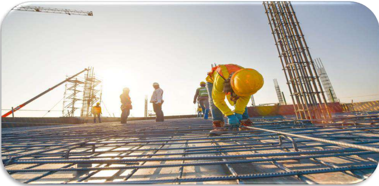
الشكل رقم 19 : مرحلة انشاء المبنى
