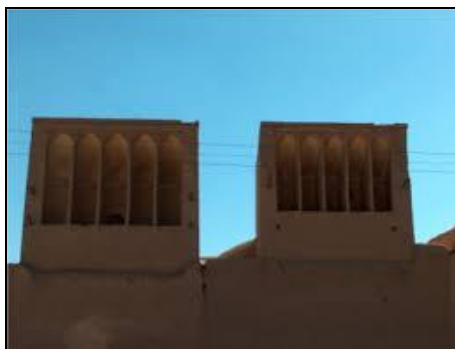
Figure I. 10: Capteur de vent unilatéral avec toit incliné (Ardakan)(Dehghan, Esfeh et al. 2013).
