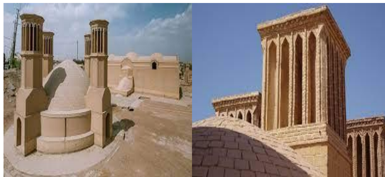
Figure I. 12: Capteur à vent octaédrique à toit plat (Yazd) (Saadatian, Haw et al. 2012)
