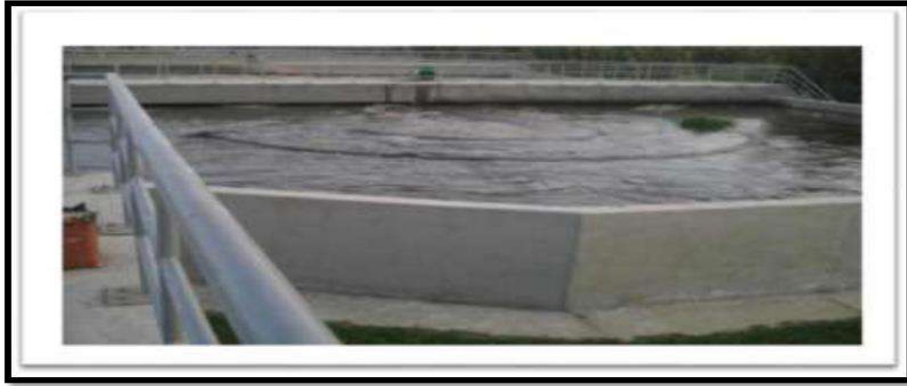
الصورة رقم III - 07 : أحواض التهوية
